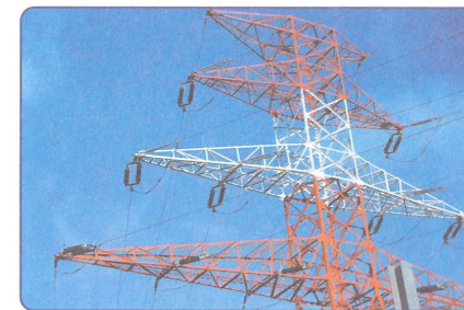
Рис. 18. Мачта линии электропередачи
